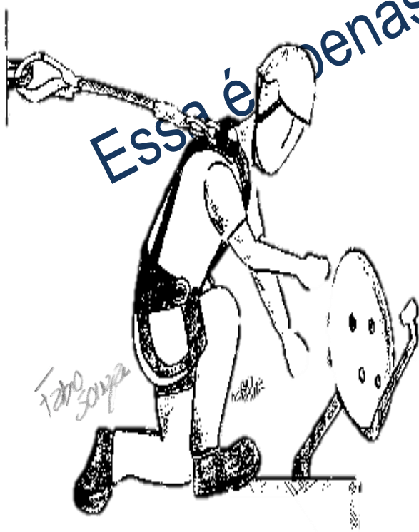
Situação de trabalho com restrição de movimento. Uma ótima aplicação do elemento de engate dorsal do cinturão
